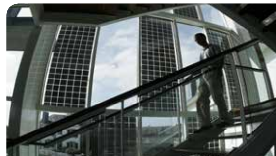
Panneaux photovoltaïques à la maison des services publics
